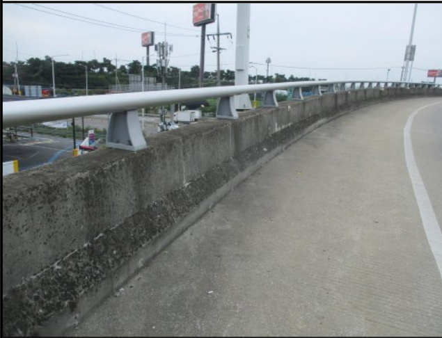
난간 및 연석 전경
