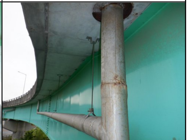
바닥판 캔틸레버, 배수관 전경
