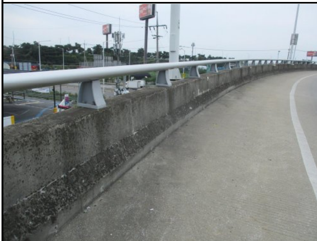
난간 및 연석 전경
